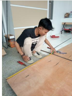
Gambar 3. Pengukuran dan penandaan multiplek
