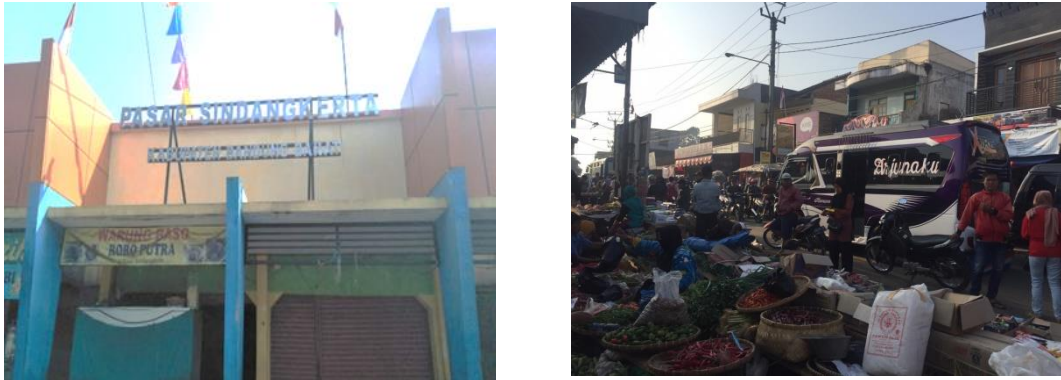
Gambar 1. Kondisi Eksisting Pasar Tradisional Sindangkerta, Kabupaten Bandung Barat
